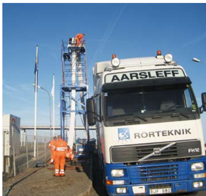
Renoveringsarbetet pågår vid hamnen i Norrköping.
