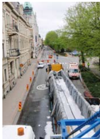
En bild från Kristianstad när Aarsleff Rörteknik relinade VA-systemet.
