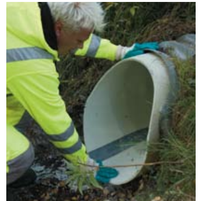
Efter relining. Ett nytt rör inne i det gamla.
