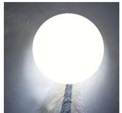
Det nya röret inifrån. Infodringen medför minimal areareducering.
