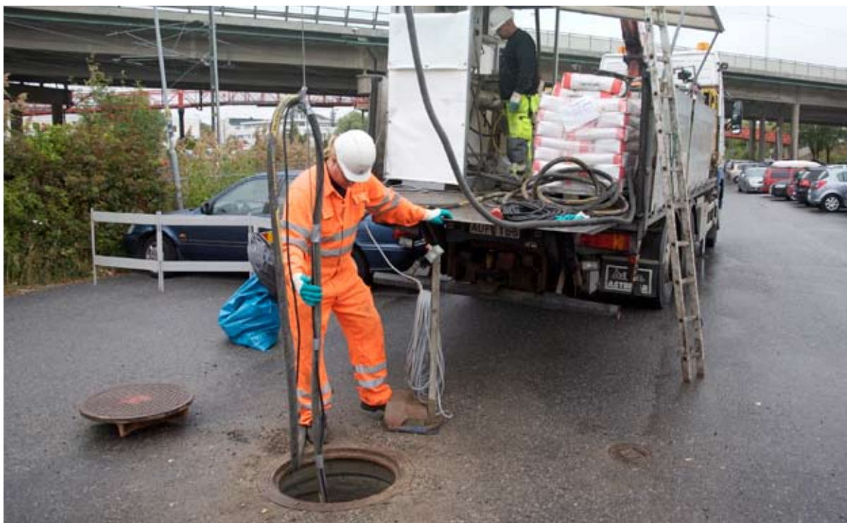
Aarsleff Brunnsrenovering kan användas överallt där man vill undvika schakt.
