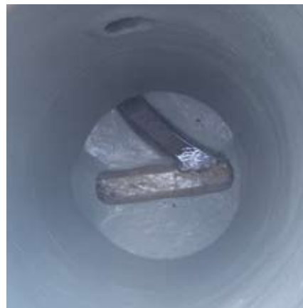
Det färdiga resultatet: En brunn som återställts och står emot framtida påfrestningar.
