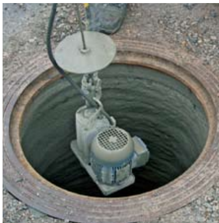
Spruthuvudet sänks och höjs automatiskt tills dess önskad tjocklek på materialet uppnåtts.
